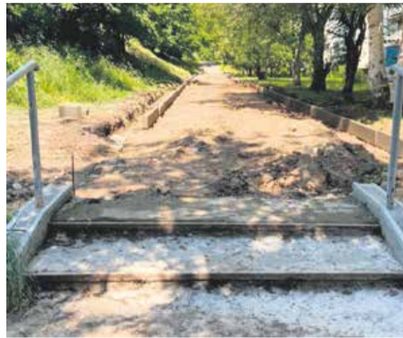
Сейчас в микрорайоне Солнечный проходит множество работ по благоустройству территории. Так, кроме дворов оборудуют «Семейный парк» и в ближайшем времени планируют продолжить реконструкцию окружной дороги
