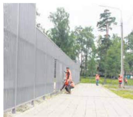
Заканчиваются работы по строительству баскетбольной площадки в роще Каштаковской. Когда высохнет краска, здесь смогут играть как дети, так и взрослые. Каштаковская роща всегда была популярным местом прогулок местных жителей. А теперь здесь можно выбрать отдых на свое усмотрение: это могут быть тихие прогулки или занятия спортом
