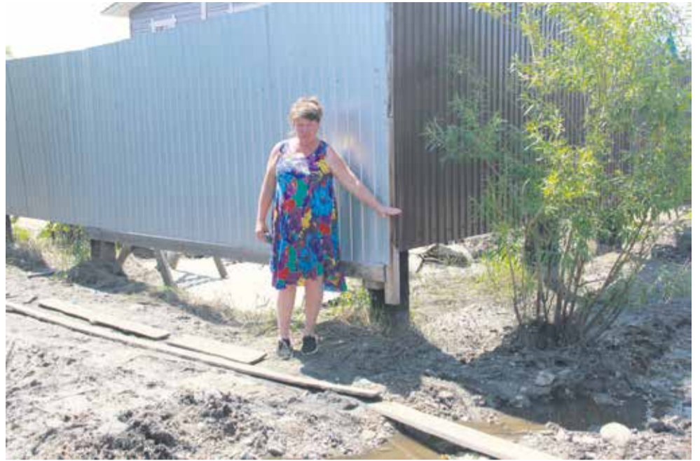
Клавдия Петровна ПравOVEROVA показывает, до какого уровня вода доходила на улице. Сейчас здесь завершены работы по прокладке переливной трубы диаметром 315 миллиметров, что позволило максимально снизить уровень воды
