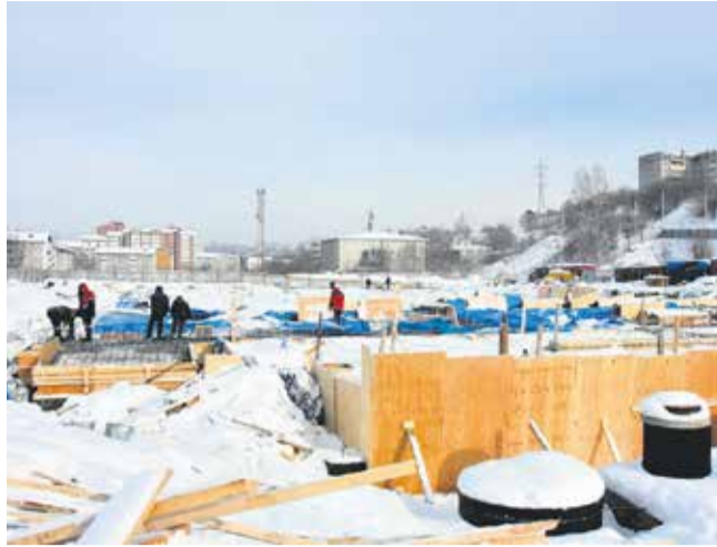
Так будущий каток выглядел в феврале 2021 года: еще нет фундамента, и под снегом не разглядеть, ведется ли работа вообще
