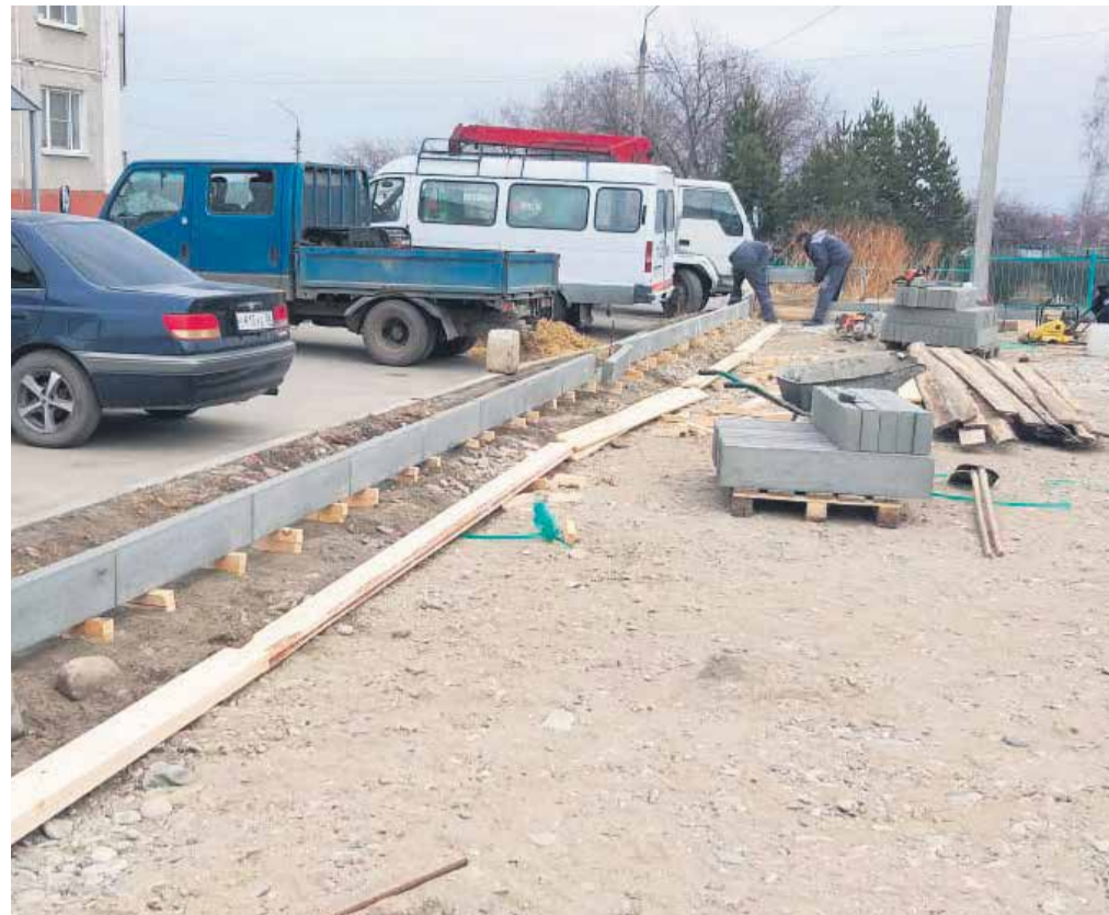
Идут ремонтные работы на улице Ярославского, 215. На территории обустраивают многофункциональный корт, зону для воркаута, крытую площадку с тренажерами, детскую площадку с резиновым покрытием, зону отдыха. Также будет выполнено озеленение. По плану работы должны закончить до 1 августа 2021 года
