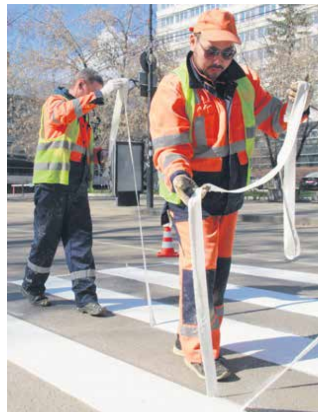
Вот так с помощью химической ленты у полос «зебры» сохраняется четкая строгая форма. Кстати, на полосы одного пешеходного перехода тратится от 50 до 75 литров холодного пластика
