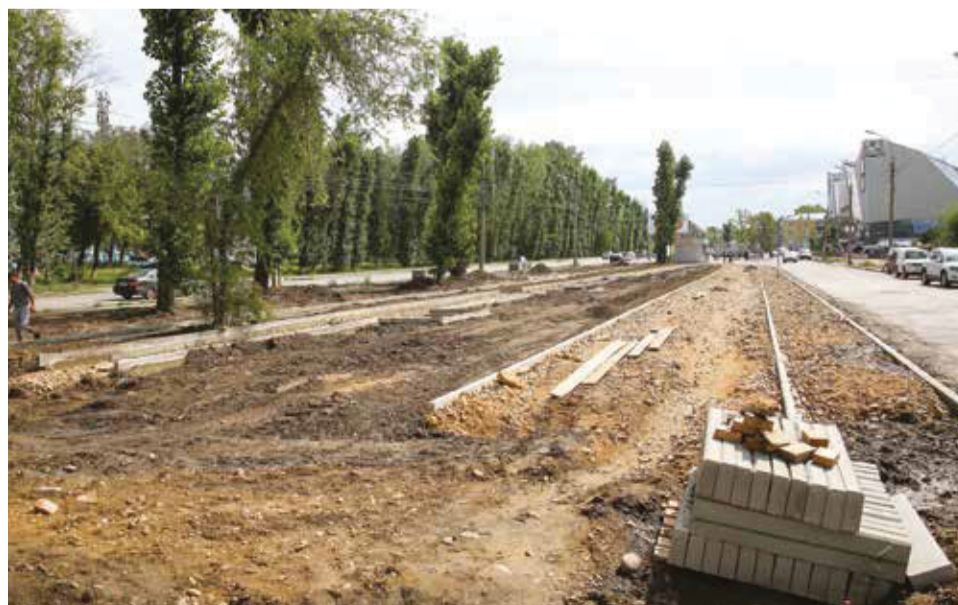
На променаде по улице Розы Люксембург уже кипит работа
