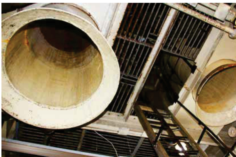
Так выглядел кондиционер (воздухозаборник) в котельном отделении, где температура поднималась до 50 °С
