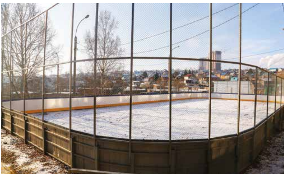
На корте в микрорайоне Первомайский демонтировали старые бортики, металлический каркас, сделали отсыпку основания, ограждение и сетку
