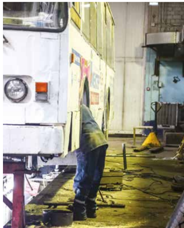
В 90-е годы ремонтные каналы пытались заменить подъемниками, но ничего не вышло: слесари опасались ходить под 12-тонными машинами
