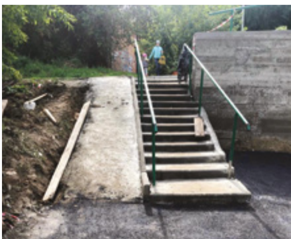
Ремонт лестницы и подпорной стены у домов № 33 и 34 в микрорайоне Юбилейный
