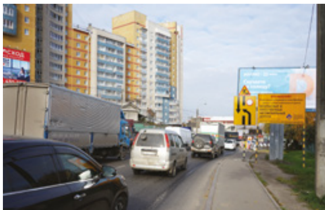
Ремонт путепровода на Джамбула едва не парализовал Свердловский округ из-за неудачной схемы движения транспорта
