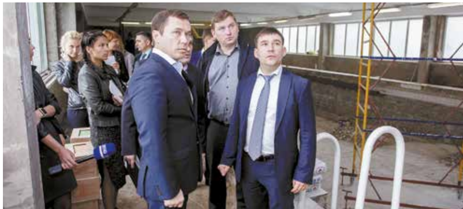
Бассейн гимназии №25 откроется после капитального ремонта в начале октября
