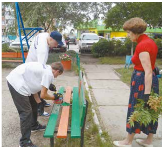
Ремонт детских площадок в округе Владислава Свердлова проходит ежегодно. Депутат закупает необходимые материалы и привлекает к работе активных жителей
