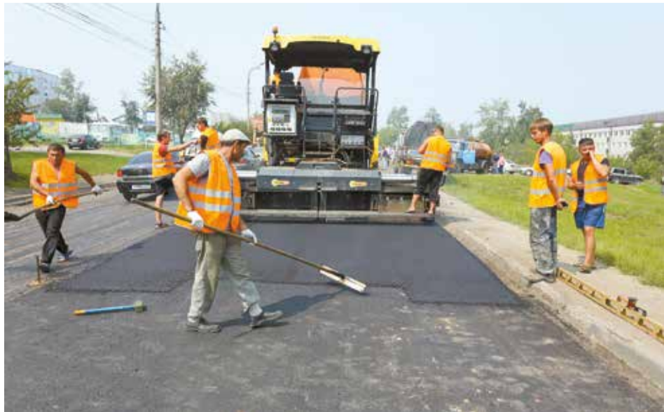
На асфальтоукладчиках установлены видеорегистраторы, что позволяет контролировать рабочий процесс. Ремонт на ул. Розы Люксембург завершат к 5 августа
