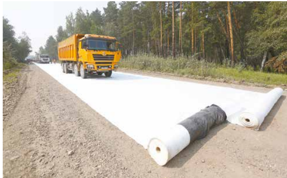
На строительство новой дороги до станции Батарейной из городского бюджета выделено 43 млн рублей. Укрепление основания выполняется с помощью укладки геотекстиля
