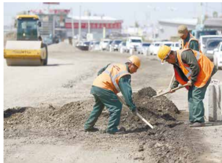
На строительном объекте установлены две веб-камеры, все происходящее на площадке транслируется в сеть. Любой желающий теперь может посмотреть, что происходит в данный момент на стройке
