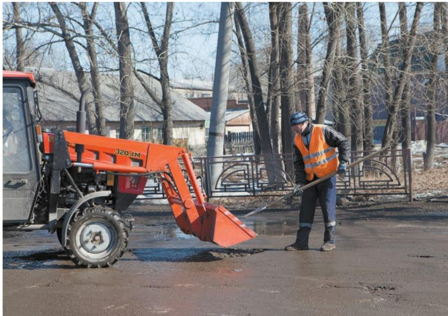
Для экстренного ремонта дорог используют отходы производства – старый перемолотый асфальт
