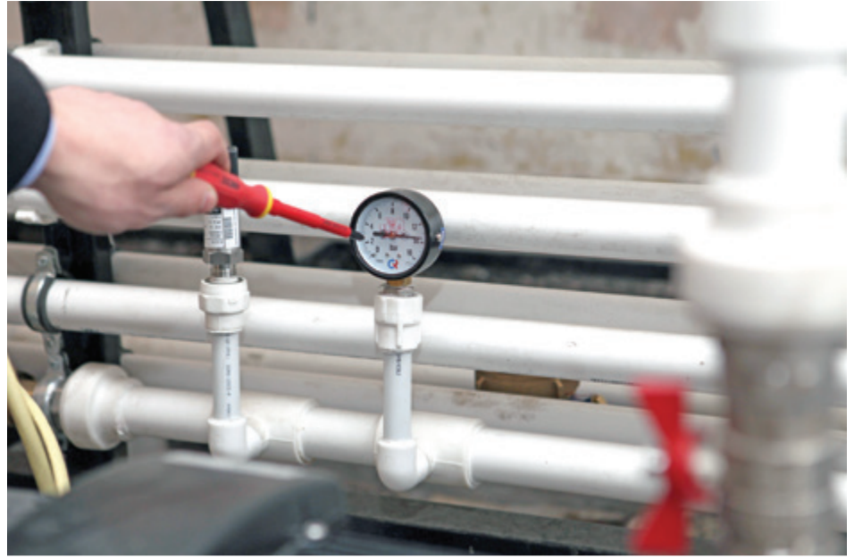
Принципиальное отличие новой системы поиска места прорыва – измерение давления внутри трубы, а не звуковая диагностика
