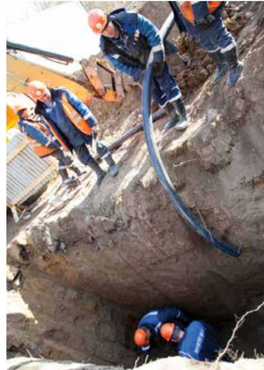
При перекладке сетей сейчас используют полиэтиленовые трубы: они долговечнее металлических в два раза
