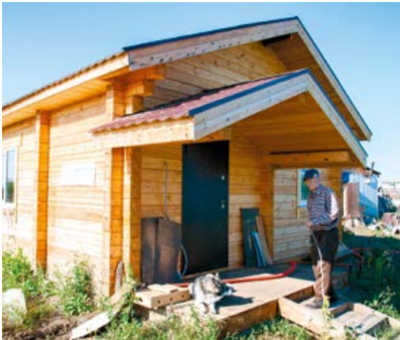
В новый дом строители провели электрический кабель под землей для безопасности и надежности
