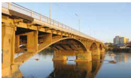
баснословные по тем временам деньги — 28 тысяч рублей. В апреле 1987 года его снесло льдом тронувшегося Иркутка. Восстанавливать мост не стали, но на его «быках» — промежуточных опорах — построили новое сооружение. Движение по нему открыли уже в июле 1898 года. В железобетонном исполнении мост, по которому мы ездим сегодня, построили в 1961 году. Изначально планировалось, что по нему будут ходить трамваи, но потом от идеи отказались.
