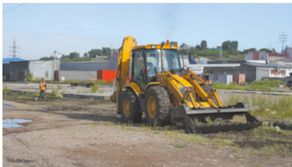
На территории будущей набережной на правом берегу реки Ушаковки расчищают территорию. Скоро это место превратится в уютное пространство с арт-объектами и площадками для отдыха
