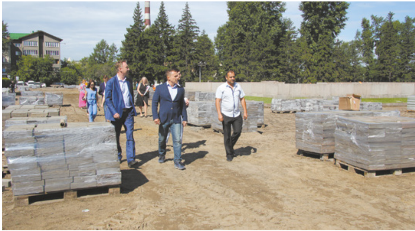
На площади мемориала «Вечный огонь Славы» уже разобрали тротуары и дорожки из плит. Вместо них будет уложена современная плитка, в оформлении также используют гранит
