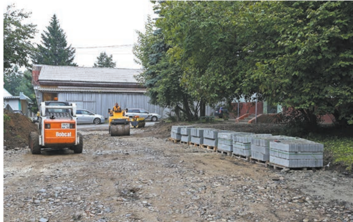
Такое глобальное обновление дворов в истории Академгородка проводится впервые. Поэтому жители с пониманием относятся к временным неудобствам и шуму строительной техники
