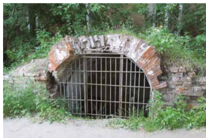
Закрытый вход в подземелье в одном из дворов по улице Свердлова
