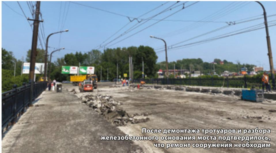
После демонтажа тротуаров и разбора железобетонного основания моста подтвердилось, что ремонт сооружения необходим
