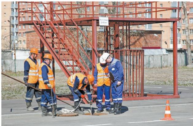
Во время аварийных работ в колодцах сотрудники обязаны выставлять оградительные дорожные конусы, определять наличие газа внутри, а после проверки плотно закрывать крышки люков
