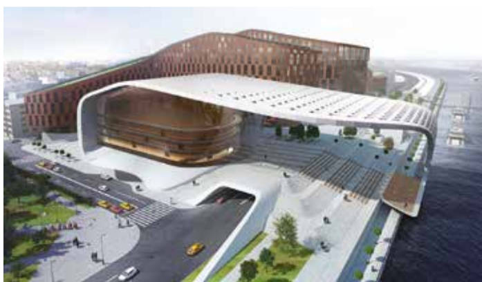
Современный концертный зал классической музыки планируется воздвигнуть на набережной Ангары, на месте бывшей ТЭЦ
