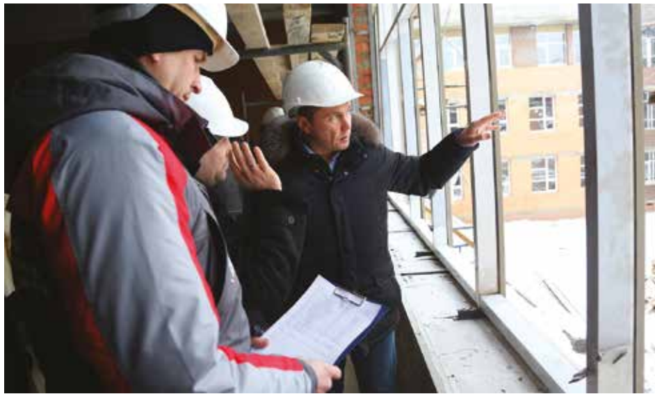
После того как здание подключили к теплу и установили в нем окна, строители смогли перейти к отделочным работам
