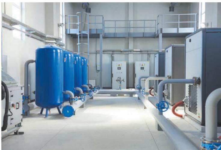
**Оборудование в недавно построенной компрессорной станции полностью автоматизированное и не требует присутствия персонала**
