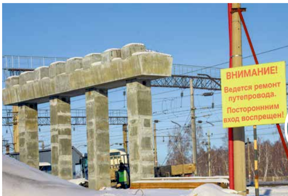
Перед вами — опоры путепровода станции Батарейной. Их будет семь. Последнюю (а если считать от начала моста, это третья) начнут монтировать буквально на днях. Фундамент под нее уже готов и по технологическим требованиям укрыт специальным материалом от мороза, как и верхняя часть каждой конструкции
