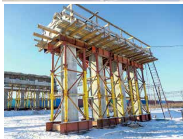
Перед вами — опоры путепровода станции Батарейной. Их будет семь. Последнюю (а если считать от начала моста, это третья) начнут монтировать буквально на днях. Фундамент под нее уже готов и по технологическим требованиям укрыт специальным материалом от мороза, как и верхняя часть каждой конструкции
