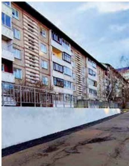
До наступления зимних холодов успели отремонтировать подпорную стену вдоль домов № 184–186 на улице Баумана
