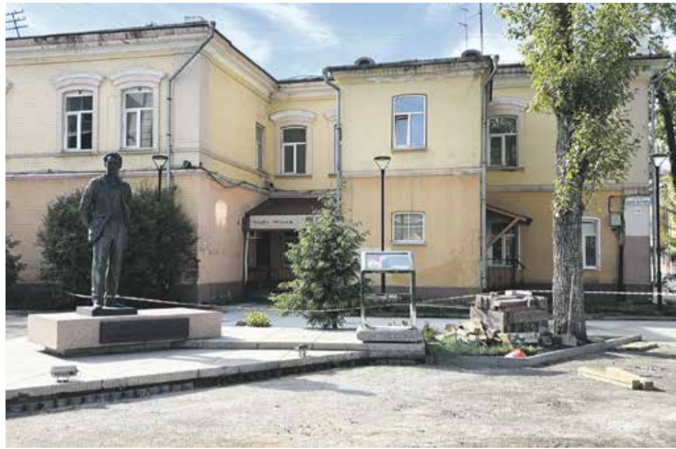
Сейчас сквер Юрия Ножилова (пересечение улиц Сухэ-Батора и Горького) немного напоминает мини-стройплощадку. Здесь уже нет старой плитки, часть территории залита бетонным основанием для укладки новой. Интересная деталь: после окончания работ в сквере установят скамейки с необычным дизайном — визуально они будут напоминать Братскую ГЭС, которую в свое время возглавлял Юрий Абрамович Ножилов
