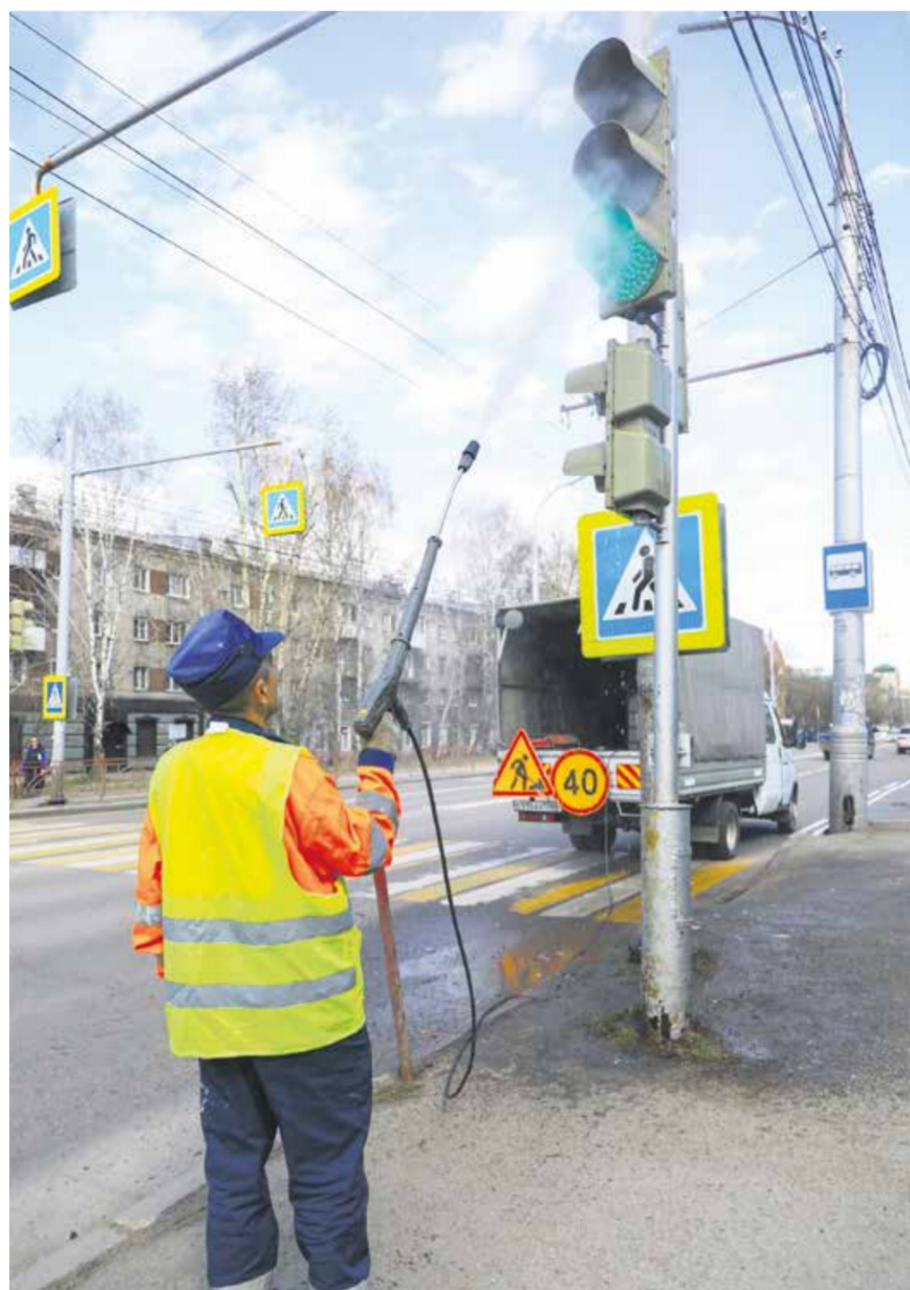
На снимке: Алексей Скоблов, электромеханик службы эксплуатации светофорных объектов «Безопасный город», приступил к самому важному этапу во всем процессе мытья светофорного комплекса. Он убирает пыль и грязь с линзы: от ее чистоты напрямую зависит яркость и видимость разрешающих и запрещающих сигналов для водителей и пешеходов. Особенно это важно в солнечный день, в непогоду и в сумерках
