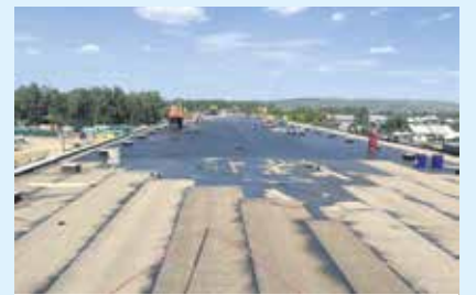
По путепроводу Батарейной будет пролегать не только новая дорога, но и удобный тротуар шириной более двух метров: здесь смогут передвигаться и маломобильные граждане, чего раньше никогда не было. Сейчас на объекте работают около 20 специалистов, все процессы идут по графику
