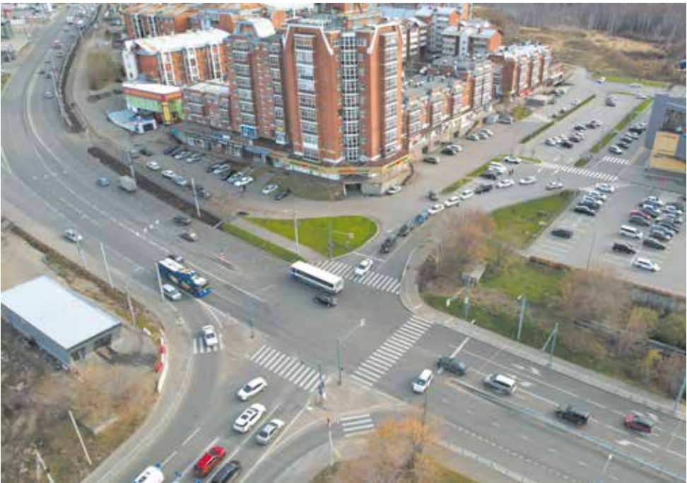
Улицу Академическую после ремонта расширили на восемь метров на участке от перекрестка с Сеченова до развязки на Старо-Кузьмихинской
