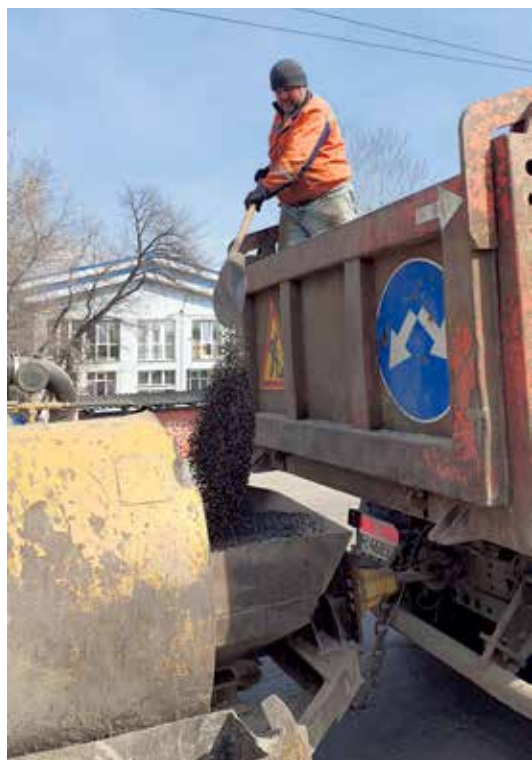
Задача дорожного рабочего Федора Ланина — следить за количеством щебня в приемнике установки и своевременно пополнять лоток приема. Делается это с помощью традиционной совковой лопаты, а необходимый запас находится в кузове самосвала
