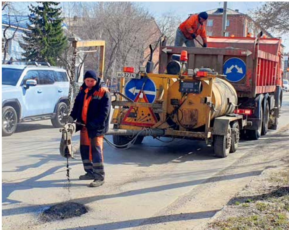
Установка БЦМ в действии: идет ямочный ремонт на улице Карла Либкнехта. На табло БЦМ (кроме прочего) имеется датчик температуры — очень важно, чтобы эмульсия, которую смешивают со щебнем и заполняют яму, была нагрета до 40–60 градусов. Именно этот диапазон является рабочим для состава — при более холодном режиме жидкость попросту застывает и становится непригодной для работы
