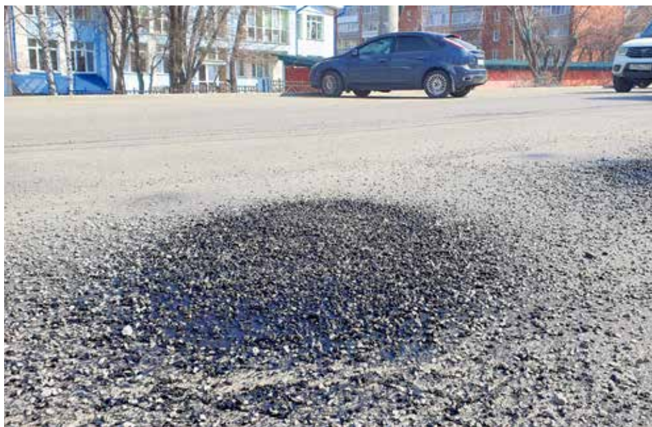
Ямы как будто и не было! Первые пару дней свежие следы ремонта заметны на дорогах — это окаменевшие заплатки черного цвета, густо покрытые щебнем. Но скоро верхние мелкие камешки откатятся к обочинам, липкий слой затрется колесами автомобилей и останется лишь ровная поверхность проезжей части
