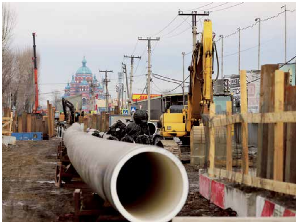
Место прокладки инженерных сетей в предместье Рабочем. Здесь одновременно прокладывают и канализационные трубы, и тепловой луч! Два предприятия — муниципальный «Водоканал» и Байкальская энергетическая компания — работают, что называется, «сверив часы». Общая длина трубопровода в границах совмещения — 518 метров. Муниципальное предприятие завершит свою часть контракта к 15 апреля и передаст фронт работ энергетикам
