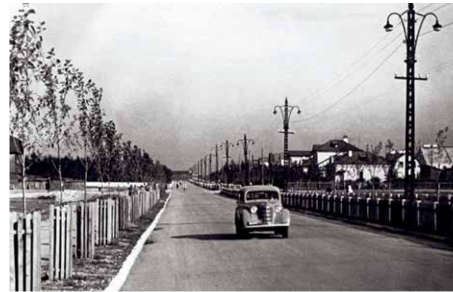
Улица Каменных Домов, она же Спортивная, Жданова, а сейчас — Авиастроителей, в 1950-х годах. По краю дороги видны необычные металлические опоры электросети — их сделали в рамках проекта по прокладыванию трамвайных путей от центра Иркутска в поселок Ленино. Из-за нехватки бюджетных средств этот проект так и не осуществился
