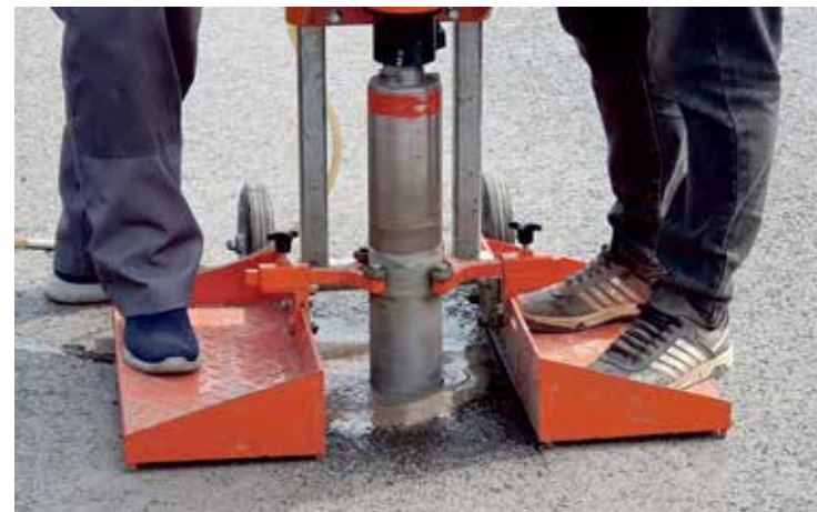
Следующий этап — забуривание режущей коронки в дорожное покрытие. Чтобы сделать пропил асфальтобетона на глубину 14 сантиметров, понадобились буквально две-три минуты
