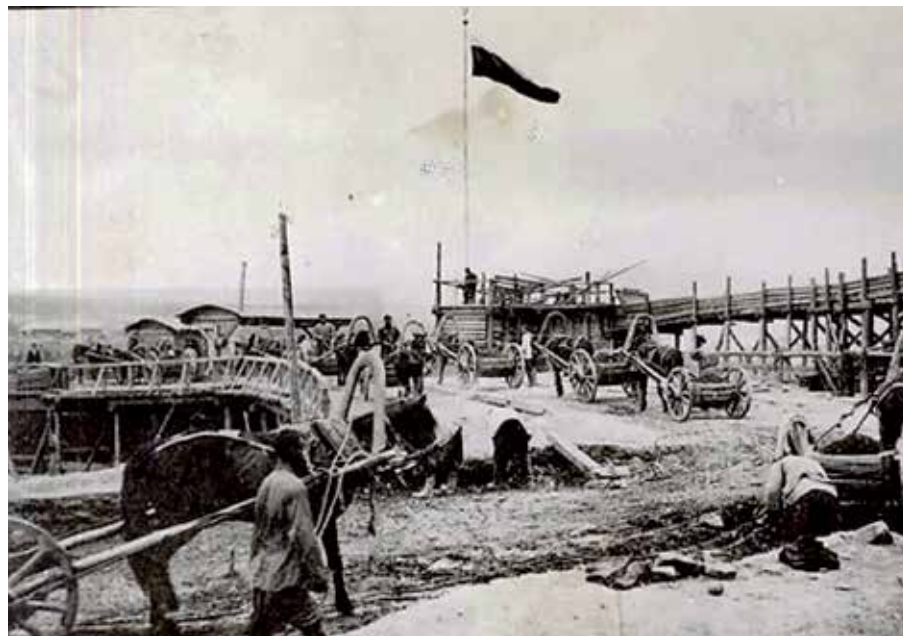
Начало строительства Иркутского авиационного завода, 1930-е годы. Главными инструментами у рабочих были топор, пила, кирка и лопата, а вместо автопарка — пара машин и 19 лошадей
