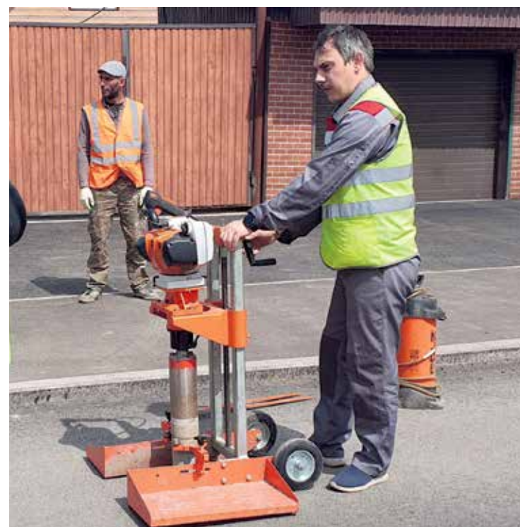
Свежеотремонтированная улица Кряжева в Свердловском округе. Начинается вырубка нового асфальта с помощью керноотборника: вынутый образец отправится на экспертизу качества. Управляет оранжевым прибором главный специалист-эксперт дорожного хозяйства Упрдор «Прибайкалье» Василий Куницын
