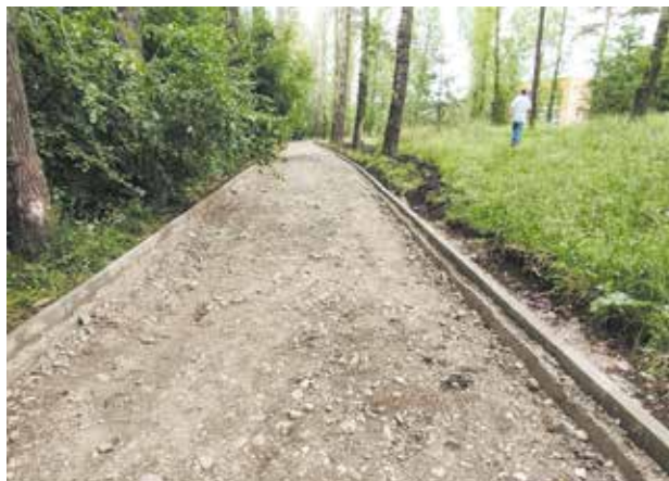
В живописном месте на территории Каштак-овской рощи в предместье Рабочем оборудуют полосу препятствий. Здесь установят элементы для сдачи норм ГТО. В проекте — создание по соседству еще одной такой же полосы, чтобы жителям можно было устраивать соревнования
