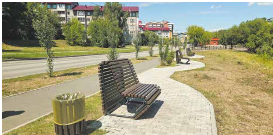
Эта пешеходная дорожка со скамейками обустроена вдоль проезжей части в микрорайоне Первомайском, параллельно Пади Долгой. В этом году строители соединили два отрезка асфальтированных тропинок, построенных в 2019 и 2023 годах, а также проложили новые вокруг пруда, логически закольцевав путь для пешеходов. Теперь гулять вокруг водоема стало еще удобнее, кататься на роликах, велосипедах и самокатах — тоже!
