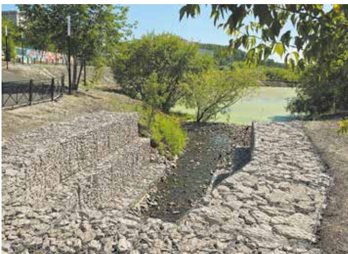
Габрионная стенка, оформленная в виде подковы, выполняет функцию подпорной стены, а также создает визуальный и экологический баланс между двумя противоположными берегами пруда в Пади Долгой. И под габрионами, и под мостом протекает речка Демьяновка
