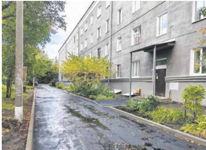
Завершаются работы по благоустройству дворов на улицах Игошина, 10 и Колхозной, 51. Там уложили новый асфальт, заменили бордюрный камень, возвели подпорную стенку и приступили к ремонту тротуара. Работы проводят за счет Фонда поддержки избирательных округов, а само облагораживание территории депутат Оксана Жучкова обсуждала вместе с жителями домов
