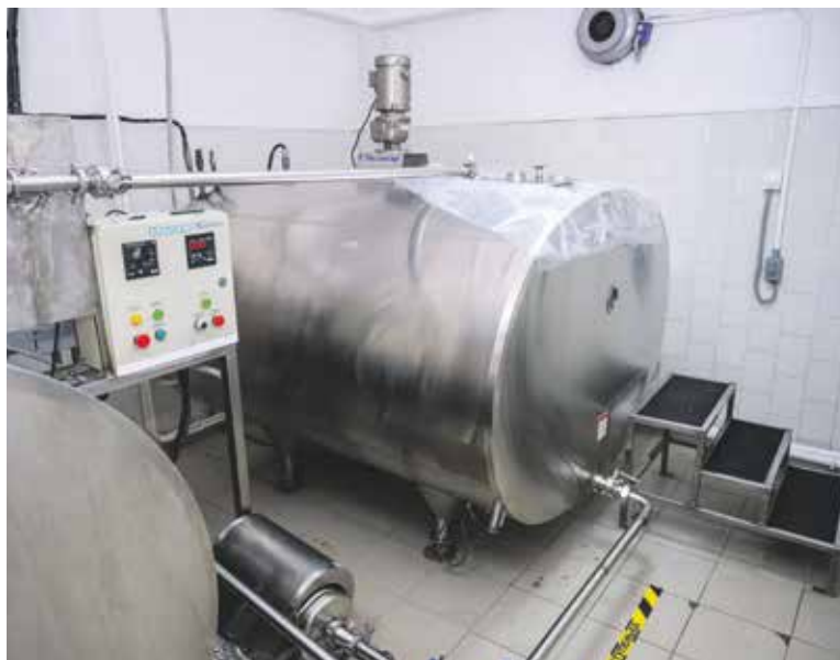
Именно отсюда начинается производственный процесс «Детской молочной кухни» — в эти емкости загружается привезенное молоко. Сразу после перекачки сырья цистерны тщательно моются, чтобы следующим утром снова принять свежую продукцию
