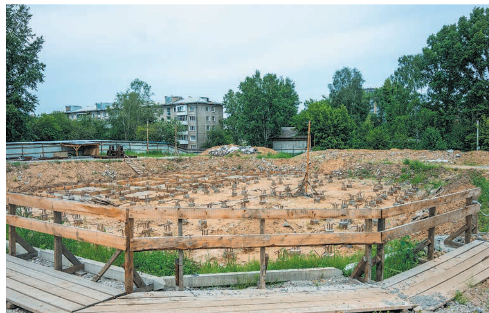
Так сейчас выглядит стройплощадка детсада в городке ИВАТУ: это лишь самое начало. В двухэтажном здании из сборного железобетона разместят группы, пищеблоку, медицинский и прачечный блоки, кабинеты логопеда и психолога, музыкальный и спортивные залы, а также необходимые подсобные помещения. Садик, рассчитанный на 140 ребятшек, планируют возвести до 2030 года
