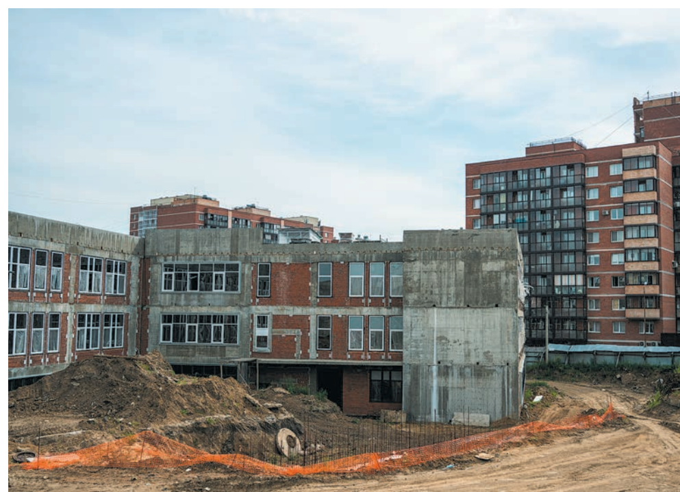
Как видите, новая школа в микрорайоне Союз строится в шаговой доступности от жилых домов. Сейчас заканчиваются бетонные работы, есть кровля, установлены внутренние перегородки и частично окна. Уже известно, что школу в Союзе назовут в честь Героя России иркутянина Эдуарда Дьяконова, погибшего на СВО в 2022 году
