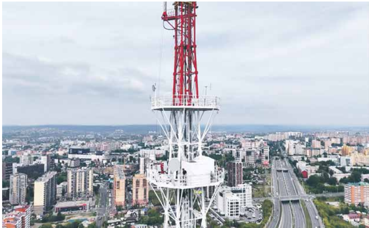
Эта площадка с основным ретранслирующим оборудованием находится на высоте 140 метров иркутской телевизионной башни. Именно сюда поднимали бухты со светодиодными светильниками, которые затем разматывались и крепились от самой верхней точки телебашни — с высоты 180 метров
