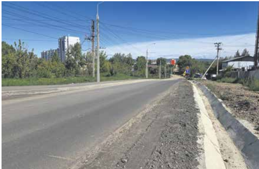
Участок улицы Томсона у перекрестка с Щербакова. Здесь ремонт дороги сделан на 90 процентов. На примыкающей части (она на дальнем плане фото) сейчас идет прокладка коммуникаций, а дорожники благоустраивают уже доступные отрезки. Как только будут закончены работы, на всем протяжении улицы строители уложат второй слой асфальта, нанесут разметку и проведут озеленение газонов. Ширина проезжей части здесь — от семи метров
