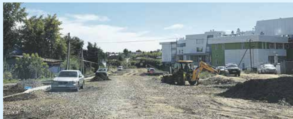
На фото — улица Ярославского. Справа — самая большая школа в городе (в процессе завершения строительства) и парковочный карман на 53 места. Слева — тротуар, газоны и места для параллельной парковки автомобилей. Дорога оформлена и готова к следующим этапам ремонта
