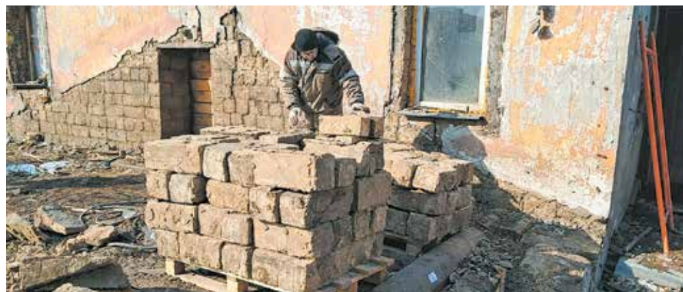
Приступая к работе по разбору здания, строители волновались, получится ли извлечь саманный камень так, чтобы использовать его при реставрации. Из всего объема дома неплохо сохранились блоки только на втором этаже, в мезонине, и на первом — в верхней части стен. По словам прораба Дмитрия Тютрина, стены разбирали прямо руками: где-то просто саман выдергивали, где-то чуть поддевали перфоратором. В итоге для будущего восстановления строителям удалось сохранить саманный камень даже с двойным запасом по количеству!
