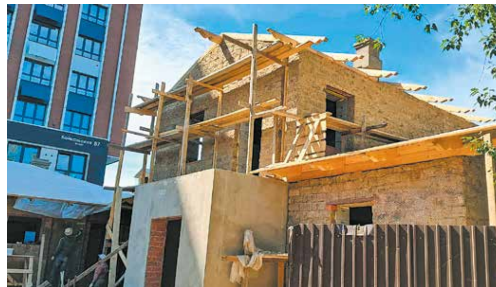
На этом фото виден процесс отделки здания саманным камнем: второй этаж уже готов, а входная группа еще нет. Строители отмечают, что и внешняя облицовочная кладка здания, и даже штукатурка выполнены дедовскими приемами — реставраторы сумели добиться соответствия старинным технологиям
