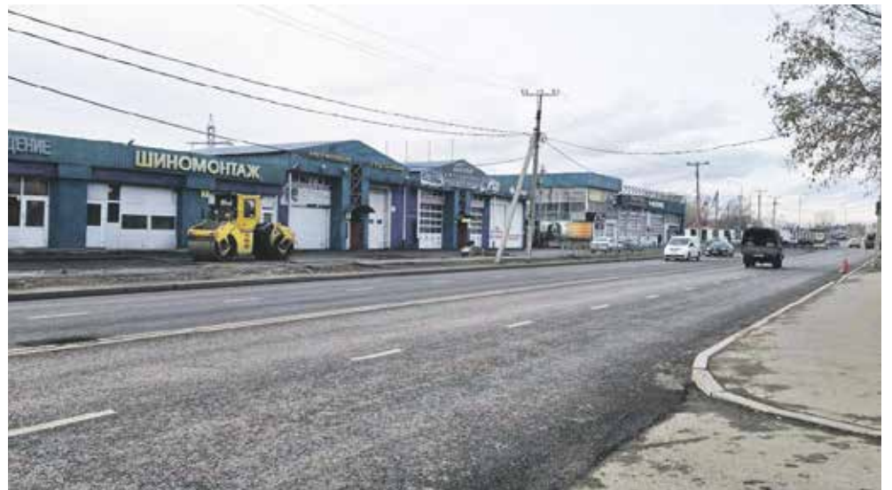
Депутат Татьяна Марченко приняла участие в выездной встрече, где осматривали восстановление улицы Баррикад. Она была закрыта для проезда с лета 2023 года. В это время проводились работы по прокладке труб. В итоге выявили замечания, которые подрядчик будет устранять в ближайшее время
