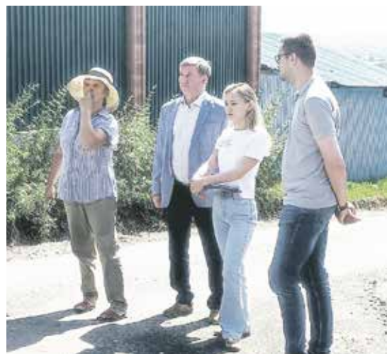
Депутат Юрий Коренев вместе с представителями администрации города и жителями избирательного округа № 21 контролирует проведение ремонтных работ на дорогах частного сектора. Важно, чтобы ремонт полотна был выполнен качественно
