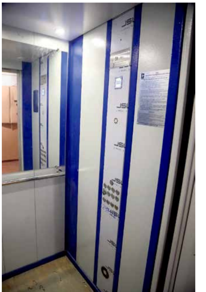
Так выглядят обновленные и безопасные лифты, которые меняет Фонд капитального ремонта. Всего в Иркутске 1497 домов, в которых 2850 лифтов
