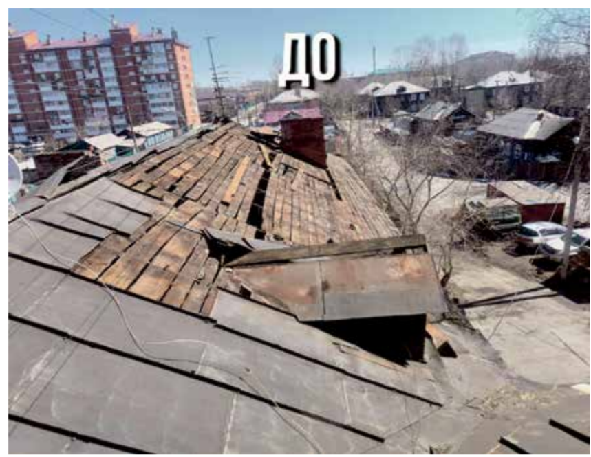
Ремонт крыши дома № 70/14 на улице Напольной в Иркутске: до и после. Здание построили в далеком 1955 году, но ремонт кровли ни разу не проводился, несмотря на значительный износ. В процессе работы там заменили покрытие, деревянные элементы с оформлением выходов на кровлю и ремонт слуховых окон, установили защитные решетки
