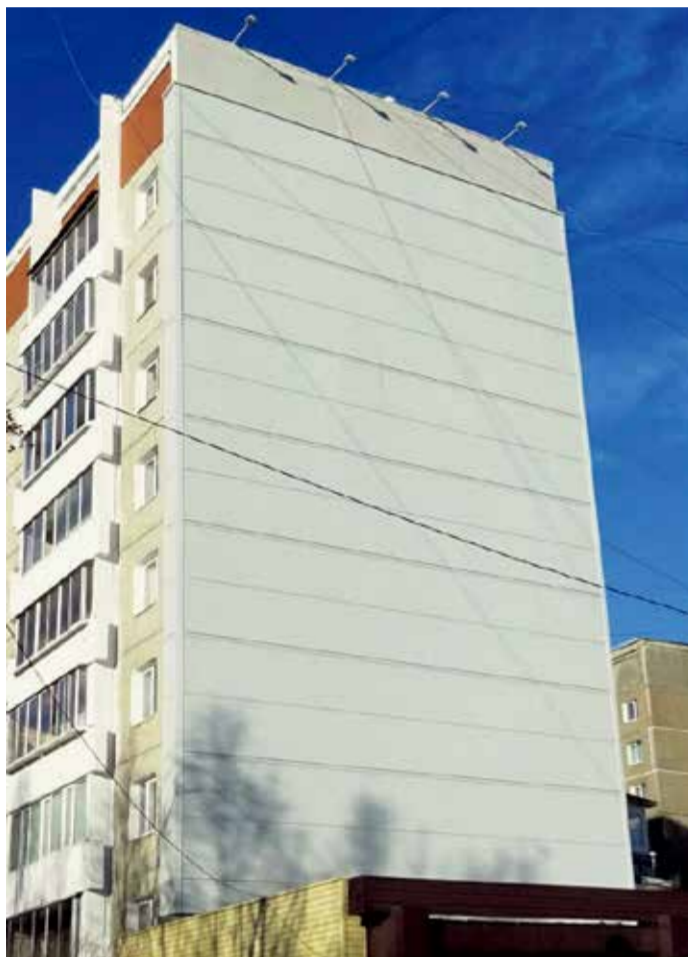
На фото — новый фасад дома № 70 в микрорайоне Университетском. Сборка панелей, изготовленных по современной технологии, заняла всего две недели. Это бескаркасная система, на которой в дальнейшем можно нарисовать мурал (вид монументальной живописи, который в последние годы украсил многие дома в Иркутске. — Прим. ред.)
