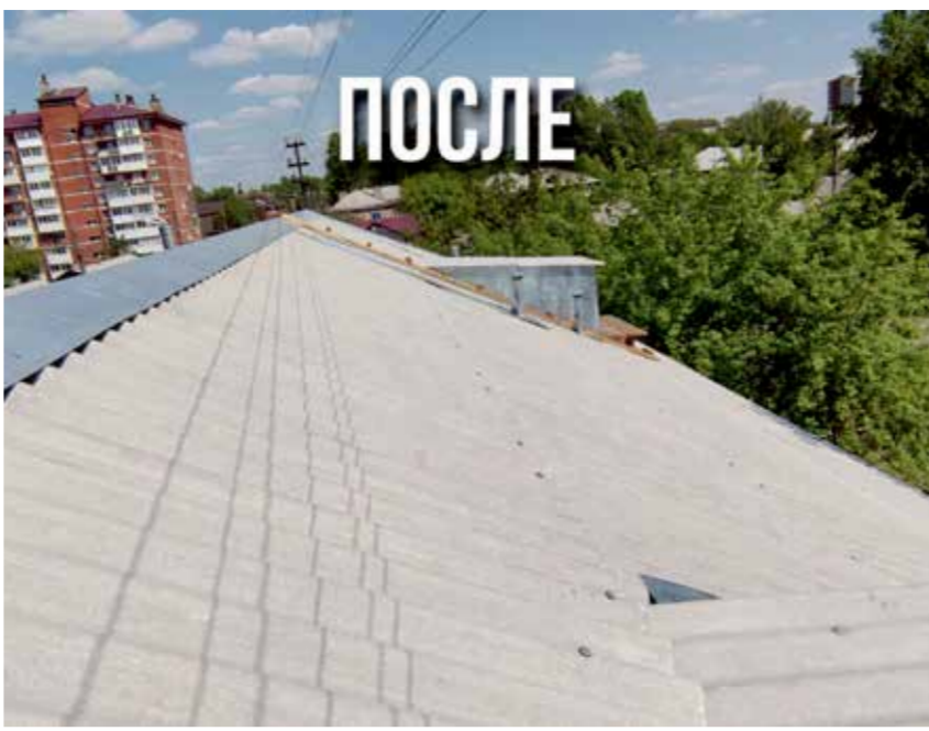
Ремонт крыши дома № 70/14 на улице Напольной в Иркутске: до и после. Здание построили в далеком 1955 году, но ремонт кровли ни разу не проводился, несмотря на значительный износ. В процессе работы там заменили покрытие, деревянные элементы с оформлением выходов на кровлю и ремонт слуховых окон, установили защитные решетки
