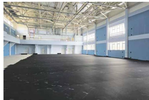
В спортивном зале окрашены стены, установлены ограждения на этаже болельщиков, строители раскатывают рулоны нижнего слоя покрытия (на ощупь, как плотный войлок или прорезиненный коврик). Скоро здесь появится спортивный линолеум, а за ним — спортивные снаряды
